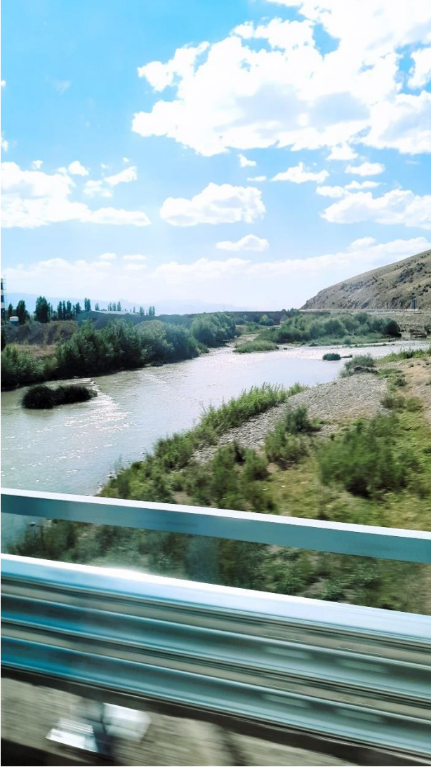
Arasın üzerinden betonarme köprüden geçtik
