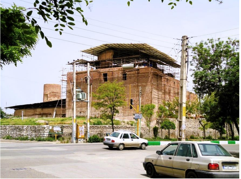
Cuma Mescidinde restorasyon çalışmaları var
