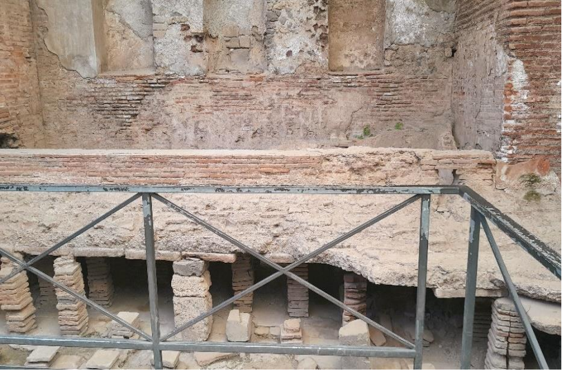
Hamamın ısıtma sistemi
