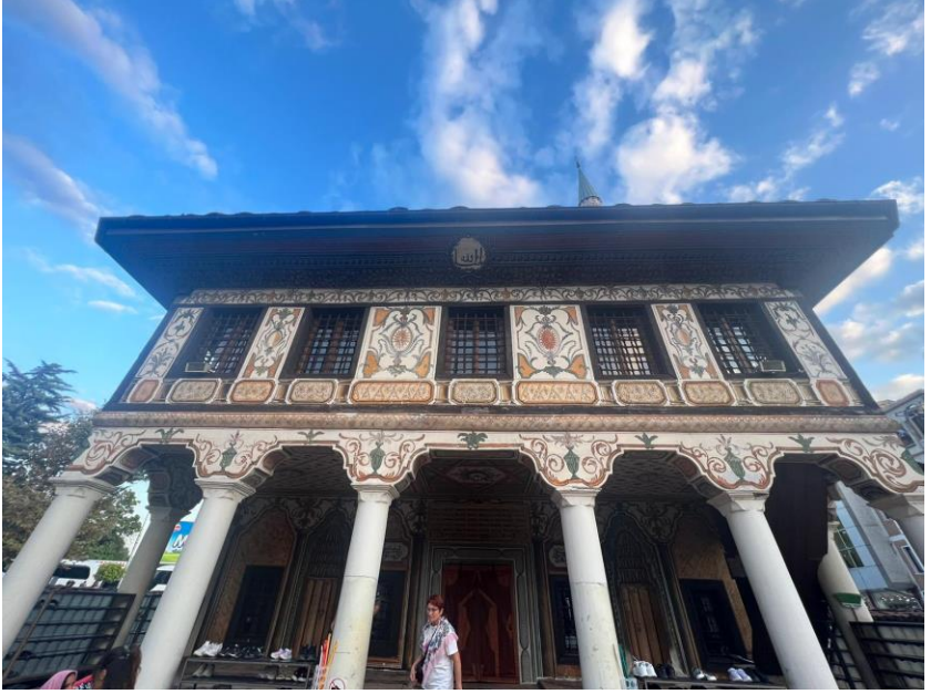
Alaca caminin ön cephesi
