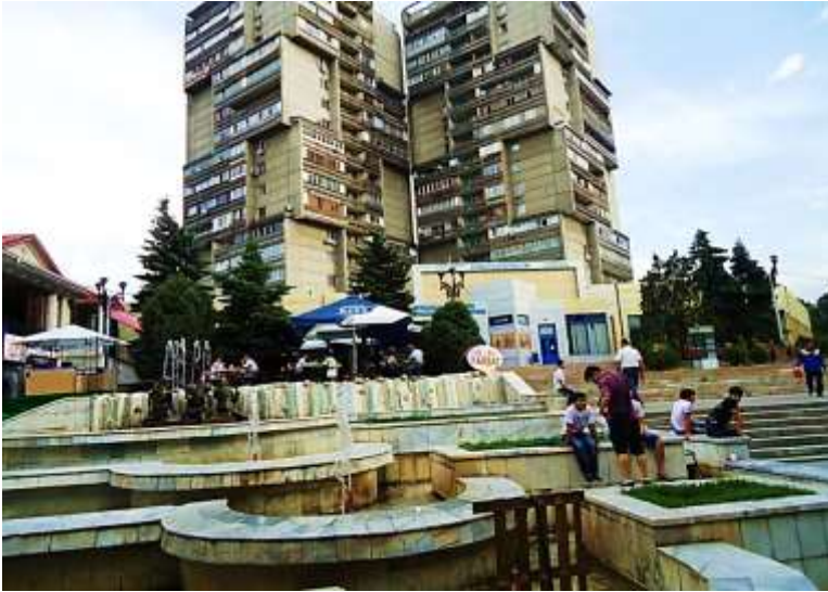
İpekyolu Caddesi. Önünde havuzlar bulunan bir bina
