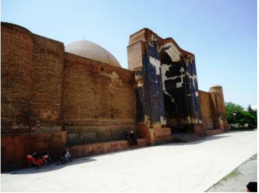
Gökmedrese'nin ta kapısı
