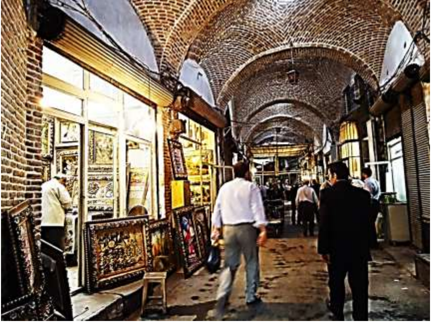
Revaklarda tuğla işçiliği
