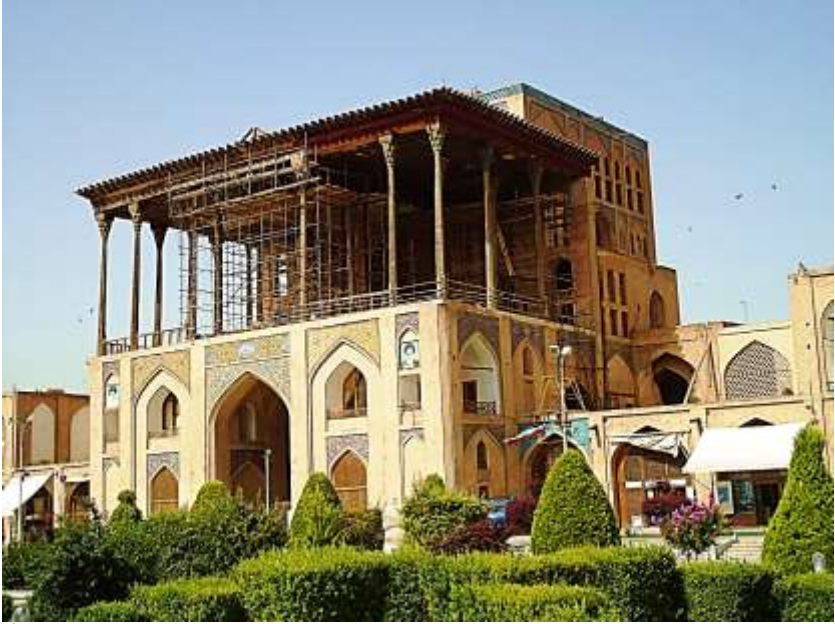
Âli Gapu Sarayı. Önden bakınca üç kat, arkada altı kat
