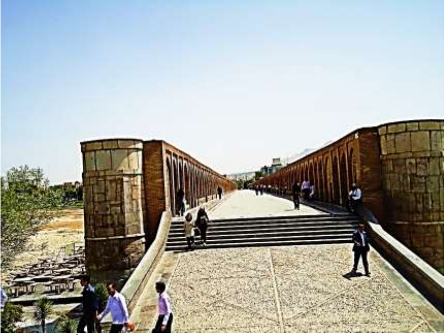
Köprünün İnkılap Meydanı tarafından girişi
