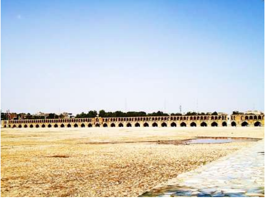
Kuru nehir üzerinde Siosepol Köprüsü
